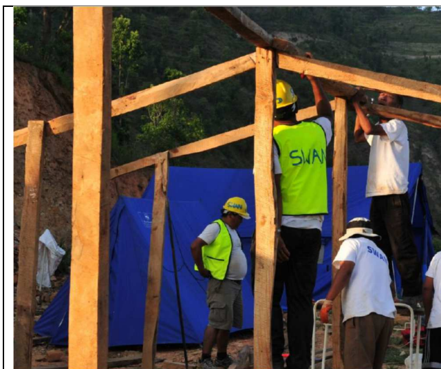
Errichtung der Not-Gesundheitsstation durch das SWAN-Team
